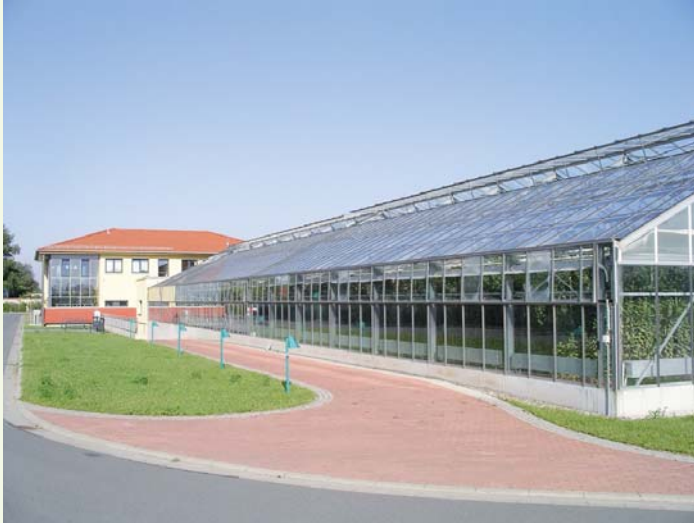
Neubau des Funktionsgebäudes mit dem Gewächshausflügel auf dem Versuchsfeldgelände
