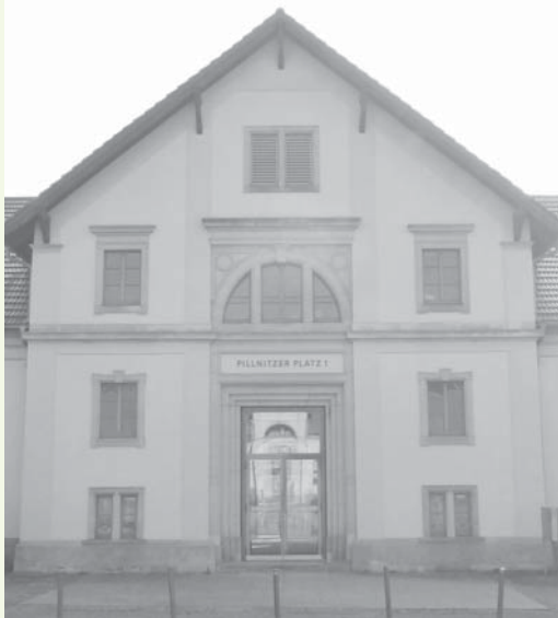
Hauptgebäude der Staatslehranstalt oben: Giebel des Gebäudes um 1925 unten: Ansicht 2012
