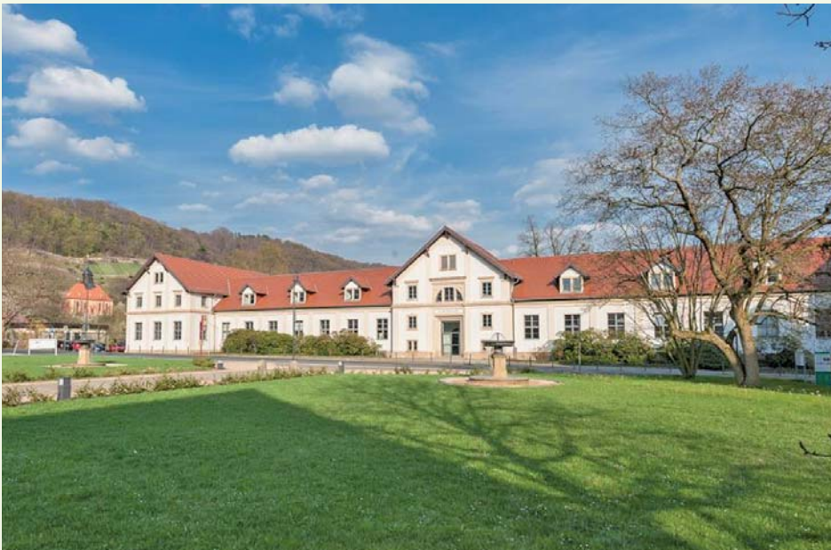
Lehrgebäude der Hochschule für Technik und Wirtschaft der Fakultät Landbau/Landespflege
