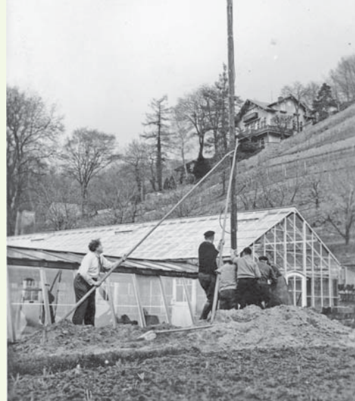
Aufrichten eines Mastes in der Weinbergsgärtnerei zur Untersuchung des Einflusses von Schwachstrom auf das Pflanzenwachstum, sogenannte Elektrokultur, 1938
