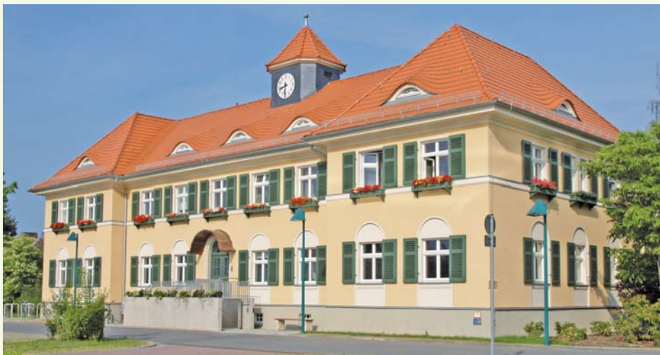
Das Gehilfenhaus nach der Rekonstruktion, Sitz der Abteilung Gartenbau
